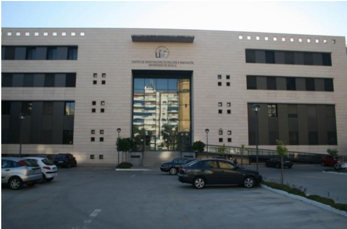
Figura 3.- Fotografía del edificio CITIUS.
