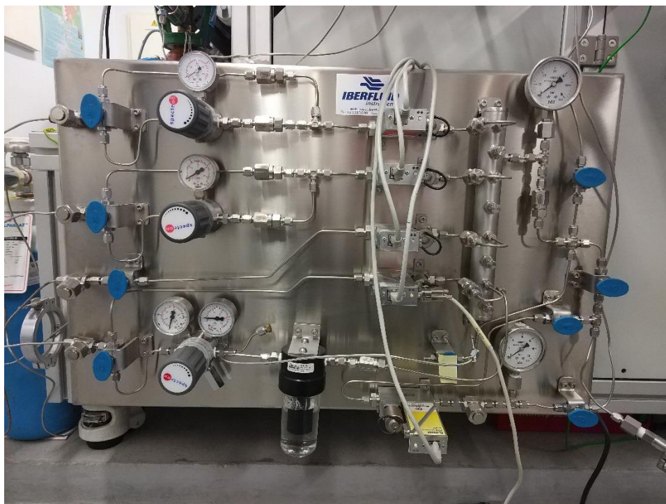
Figura 45: Sistema de introducción de gases a bajas y altas presiones en la precámara HTHP Cell.
