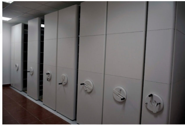
Figura 51: Sala de almacenamiento definitivo.
