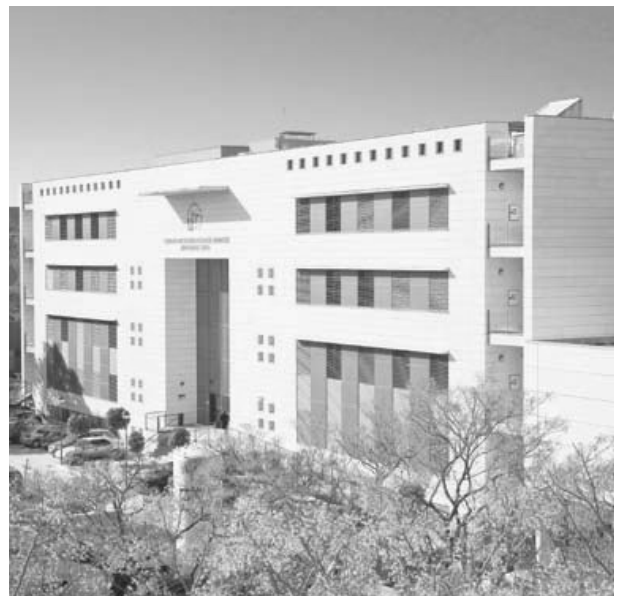
Edificio del Citius
