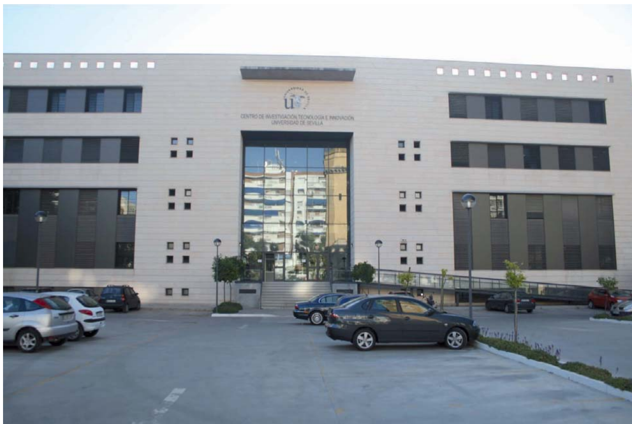
Figura 2.- Fotografía del edificio CITIUS.
